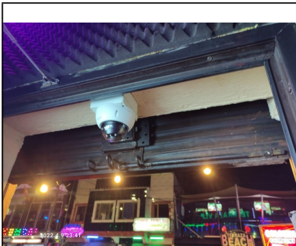
Fotografía No. 9. Vista puerta tipo cortina (recogida).
